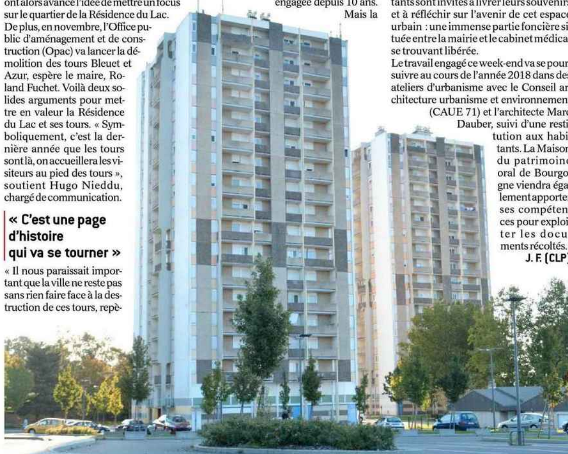
■ Le maire de Torcy, Roland Fuchet, espère que les tours Azur et Bleuet, construites en 1971, seront démolies à partir du mois de novembre. Photo Le Journal de Saône-et-Loire
