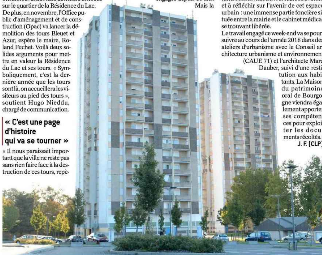
■ Le maire de Torcy, Roland Fuchet, espère que les tours Azur et Bleuet, construites en 1971, seront démolies à partir du mois de novembre. Photo Le Journal de Saône-et-Loire
